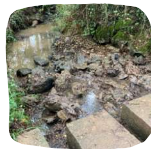
Passage à gué sur le Jauzou -Campus IMT Mines Albi
