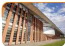
Bâtiment enseignement recherche
